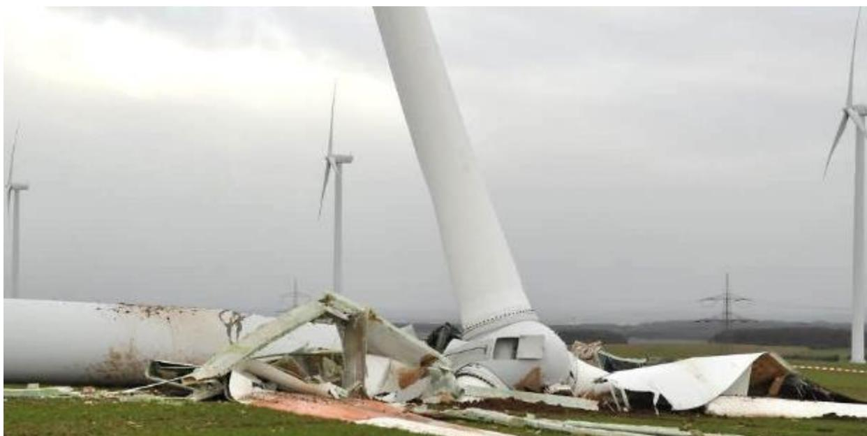
**Abbildung 48: Im Jahr 2013 durch den Sturm „Xaver“ gefällte Windkraftanlage im benachbarten Kreis Düren in Vlatten Ortsteil der Stadt Heimbach<sup>323</sup>**
