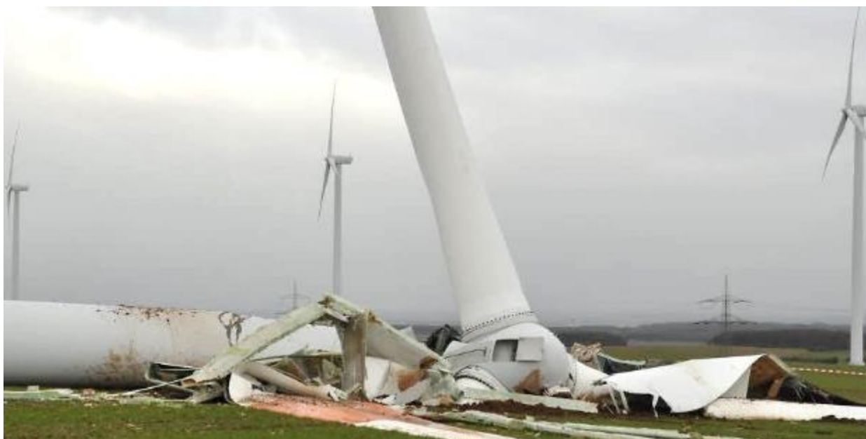
Abbildung 48: Im Jahr 2013 durch den Sturm „Xaver“ gefällte Windkraftanlage im benachbarten Kreis Düren in Vlatten Ortsteil der Stadt Heimbach 323
